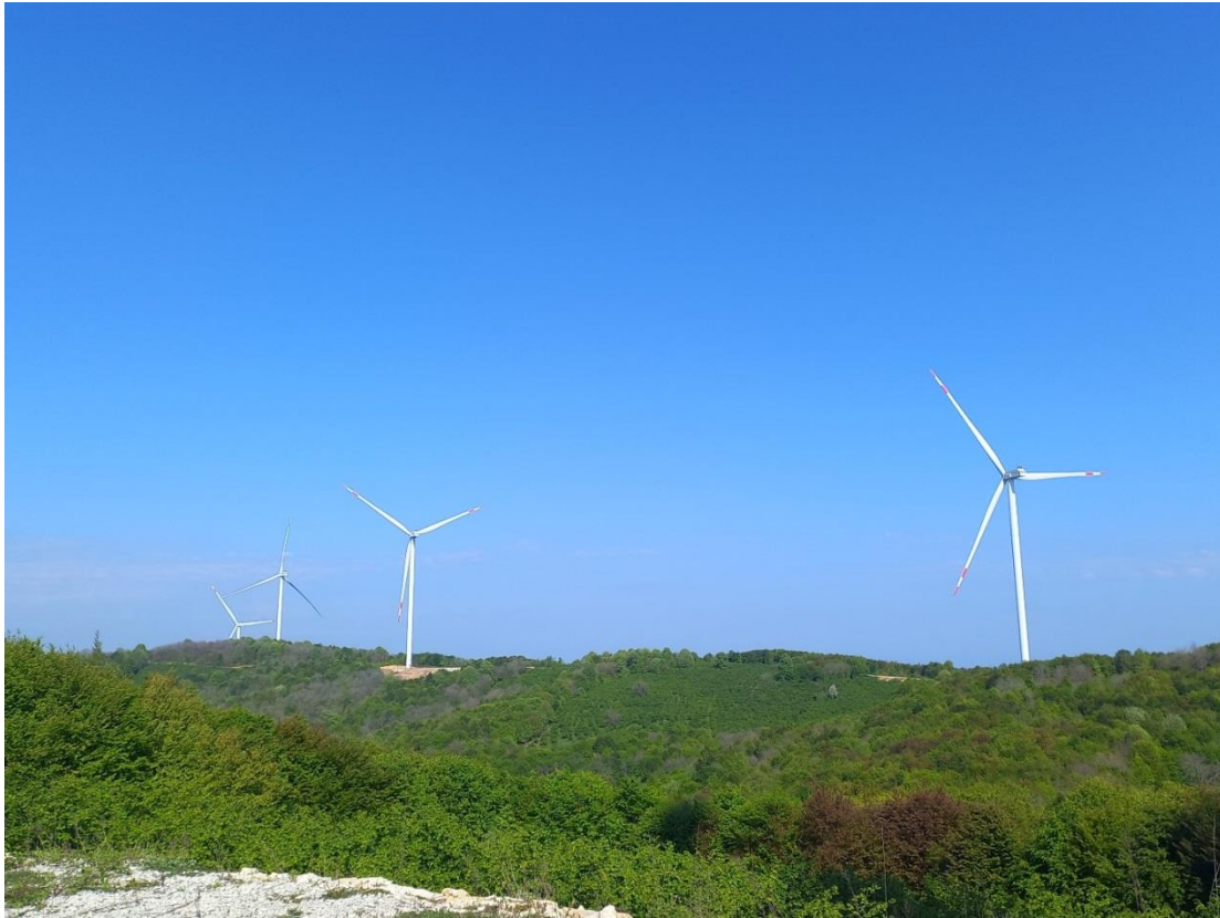
Şekil 3 Gözlem istasyonu 1'den proje sahası ve çevresi
