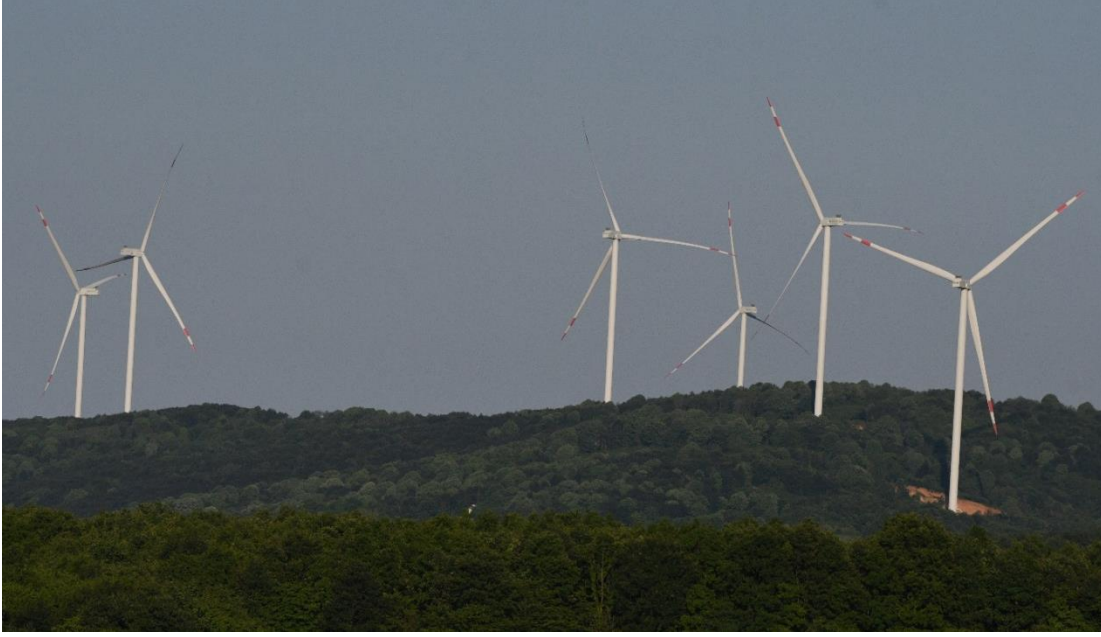
Şekil 4 Gözlem istasyonu 2'den proje sahası ve çevresi
