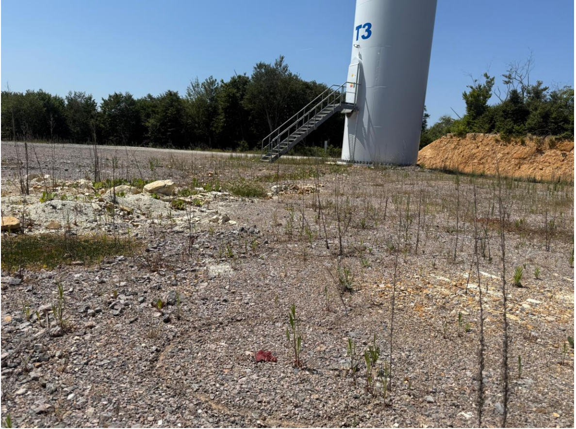
Şekil 34 T3 nolu türbinine bırakılan karkas fotoğrafı-2
