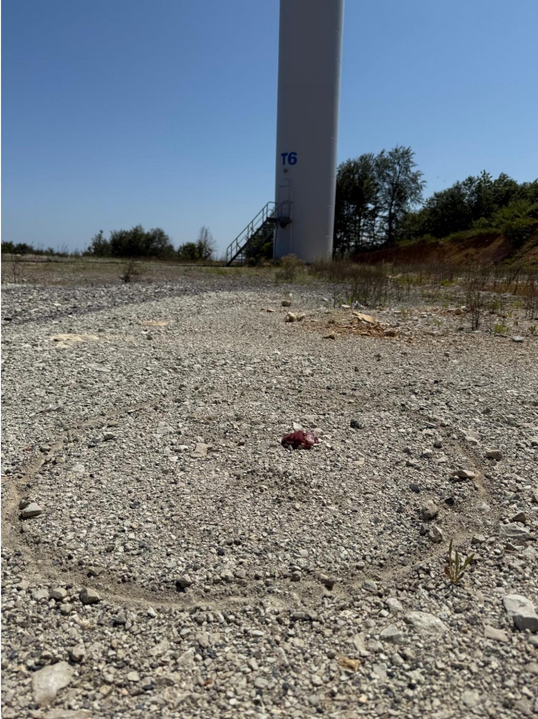
Şekil 38 T6 nolu türbinine bırakılan karkas fotoğrafı-2
